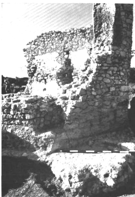
13. ábra Balatonfüred- temetői templomrom szentélye dél- keleti sarkának kiszélesedő alapozása
