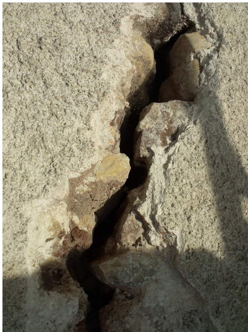
37. ábra A torony nyugati oldalán lévő repedése
